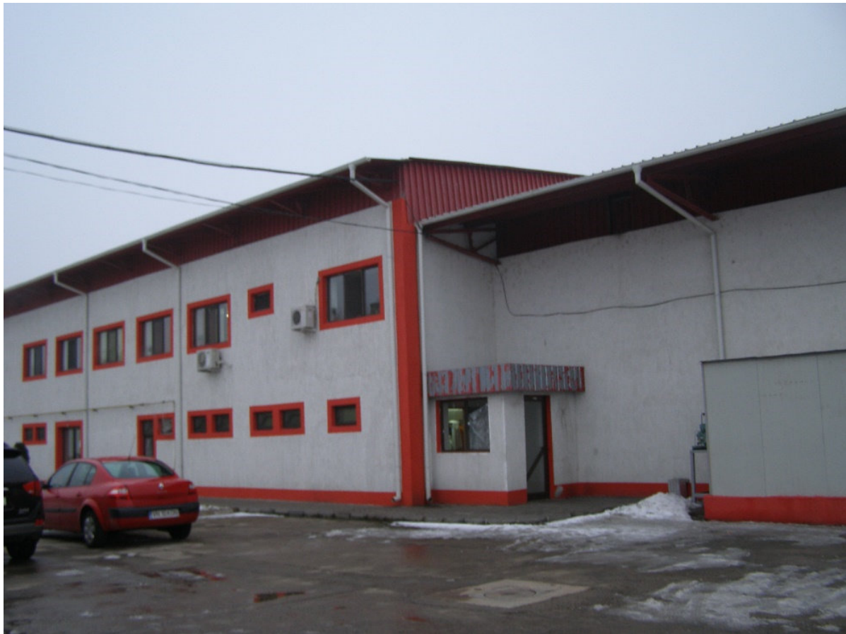
Figura nr. 1. Clădire abator păsări
