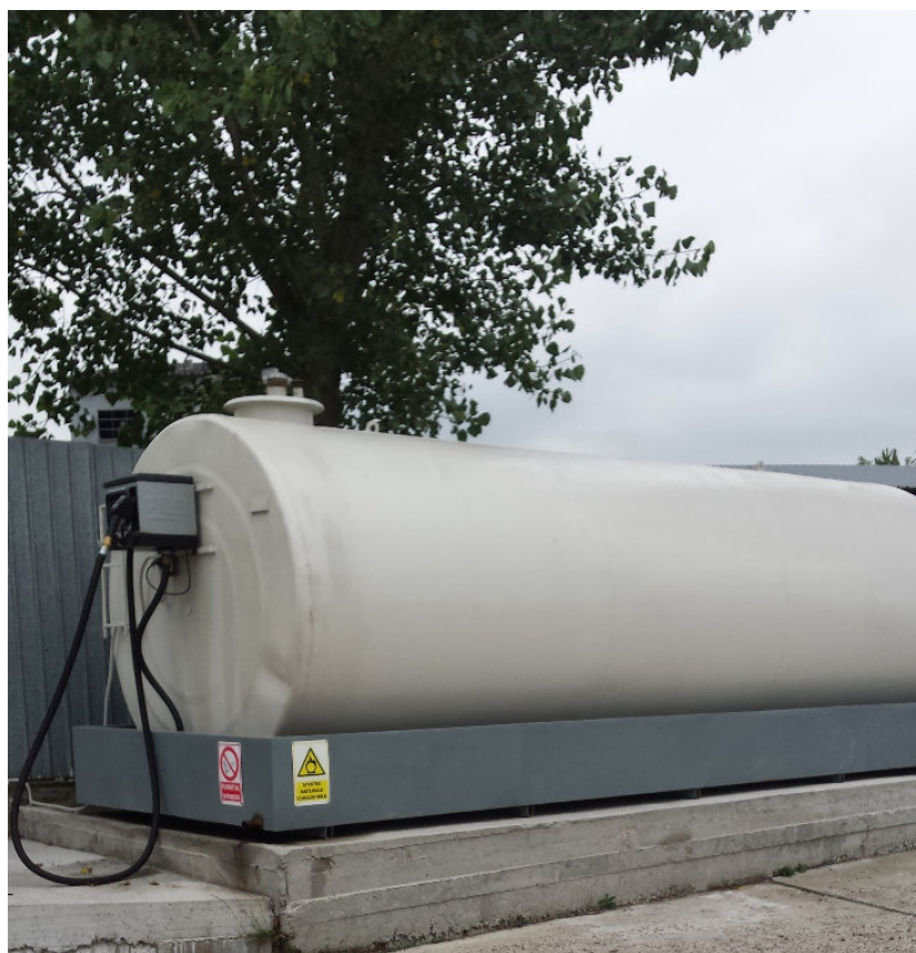
Rezervorul de motorină
