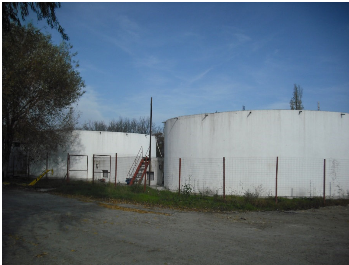
Figura nr. 4. Rezervoare de înmagazinare a apei
