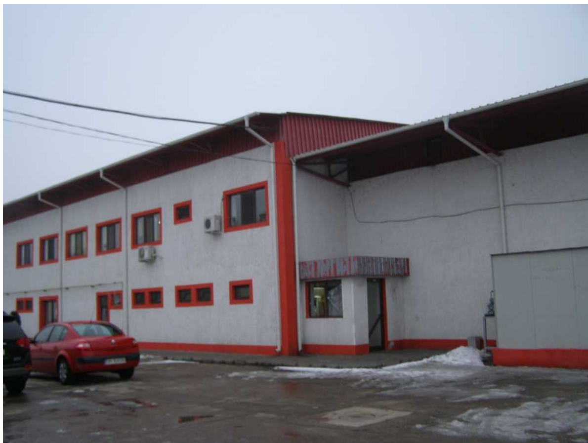
Figura nr. 1. Clădire abator păsări
