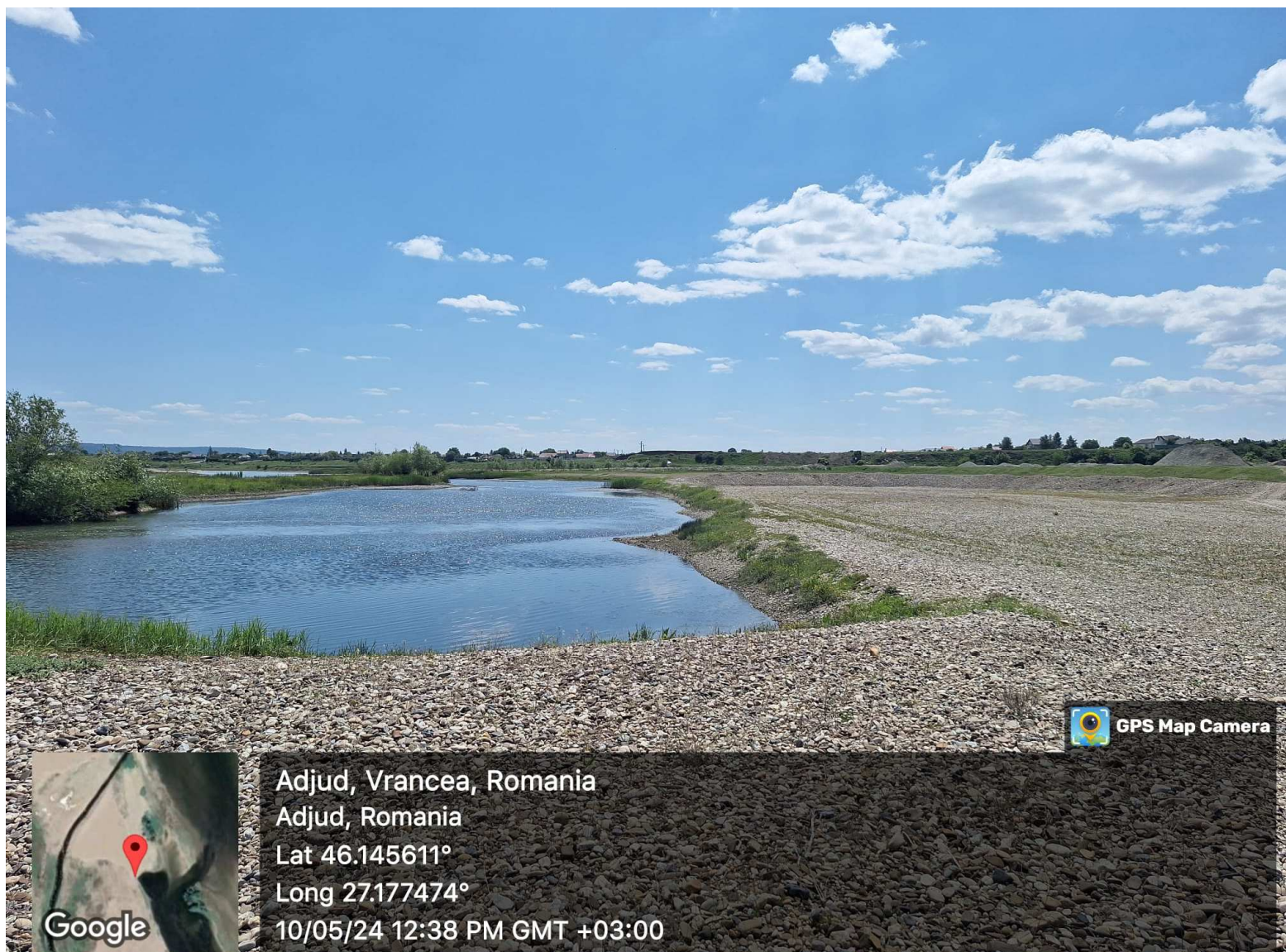
Figură 11 Amplasamentul proiectului – vedere dinspre partea de nord spre sud (Foto Divori 10.05.2024)
