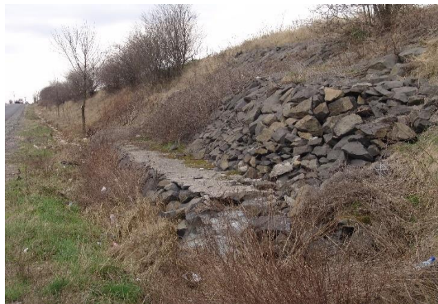
Figura 46. Utilizarea de bolovănișuri ca microhabitat este în măsură a oferi nișe suplimentare ecologice (stânga) și funcționând ca zone de drenaj a apelor de spălare ce contribuie substanțial la stabilizarea pantelor (dreapta)
