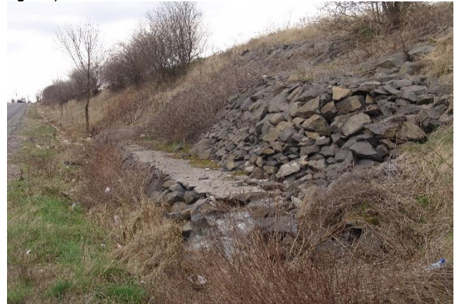
Figura 28. Utilizarea de bolovănișuri ca microhabitate este în măsură a oferi nișe suplimentare ecologice (stânga) și funcționând ca zone de drenaj a apelor de spălare ce contribuie substanțial la stabilizarea pantelor (dreapta)
