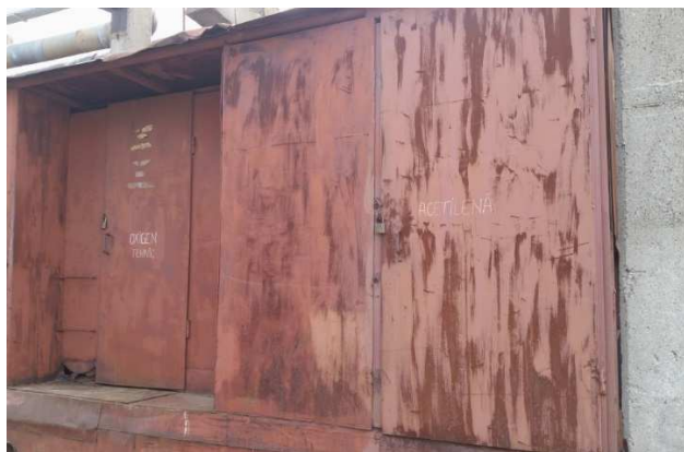
Figură 3: magazie pentru tuburi cu oxigen
